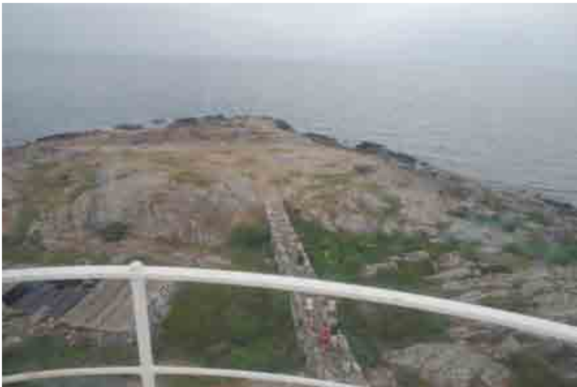
Till höger ute på Bagganäsan syns en svart diabasgång och nere till vänster det skadade locket över en bassäng, där man samlade regnvatten till en ångpanna, som förr drev en ångmistlur. Ångpannan fanns i ett hus, på den lilla plan väster om fyren dit den upphöjda stigen leder.
